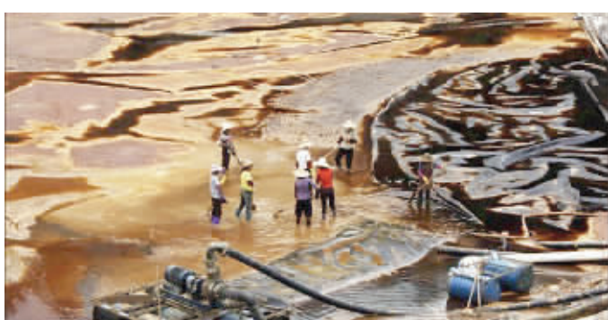
工人在清理发生渗漏的紫金矿业铜矿湿法厂污水池内剩余的污水。
