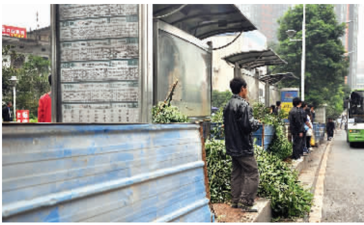
9月28日,长沙市韶山路。为改建“港湾式”公交站做准备,铁道学院站、桔园立交桥站等公交站旁的绿化带被隔离起来,大型树木也被移走。 傅聪 摄
