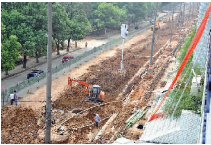
8月23日,长沙市银盆南路,几台挖掘机在路面上施工。
