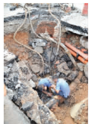
供水公司工作人员正在对爆裂的水管进行抢修。实习生 卜斯文 记者 田超 摄
