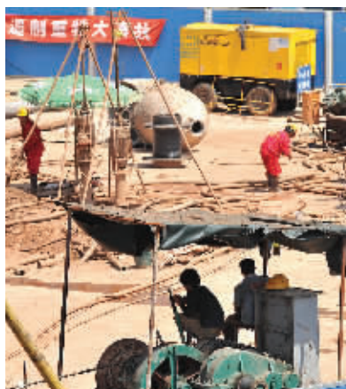
8月3日上午,橘子洲大桥东地铁施工现场,工作人员冒着酷暑工作。记者 田超 摄
