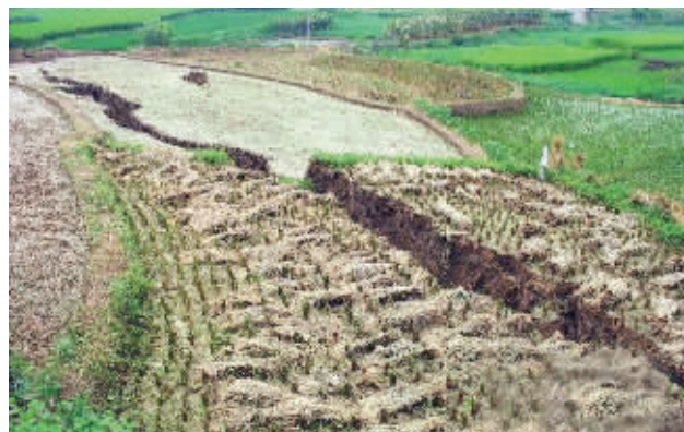
杏子铺镇虎塘村地面开裂的农田。
