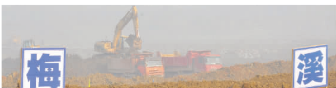
长沙市岳麓区,施工机械在梅溪湖建设现场施工。记者 田超 摄
