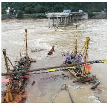
长风大桥修复工程采取打孔桩来代替原来的扩大基础桩。 新华社图
