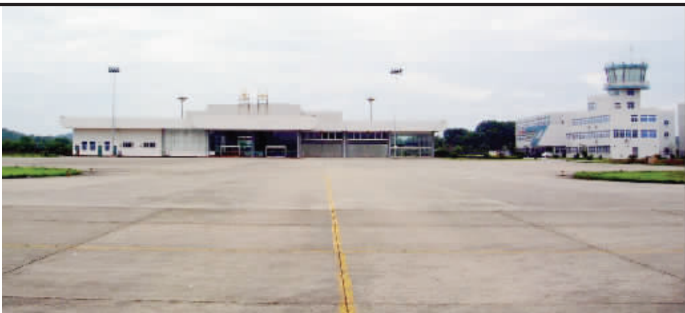
支线机场很冷清,但很多地方政府仍然渴望拥有。
