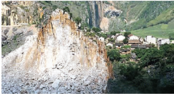
山体崩塌,巨石滚落,给村庄带来影响。
