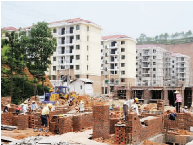
某经适房建筑工地现场。7月1日起,长沙市困难居民申请住房保障时须先接受认定。(资料图片)
