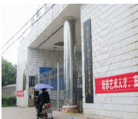
6月28日,宁乡笃材艺术学校校外,两旁悬挂的横幅在为招生造势。 实习记者 王翀鹰 摄
