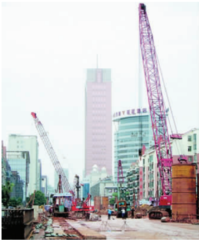
万家丽广场站的围护结构施工正在顺利推进。
