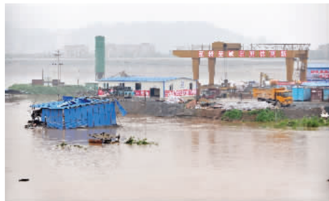
6月23日下午,长沙市傅家洲,地铁工地外侧的一些临时工棚已被洪水淹没,但工地施工目前没有受到影响。
