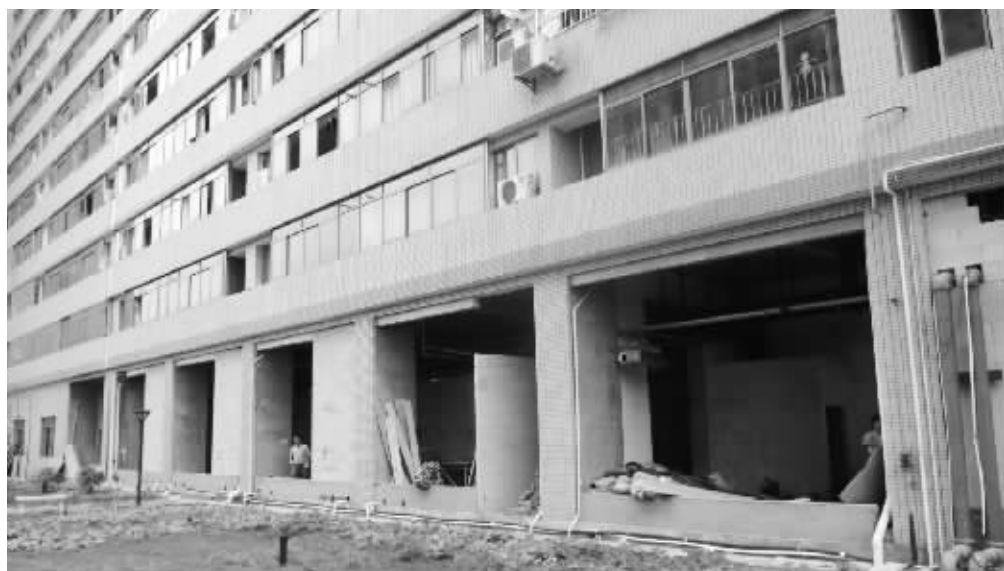
5月31日,长沙市韶山南路香颂国际四楼空中花园,架空层正在施工。 记者 龚磊 摄
