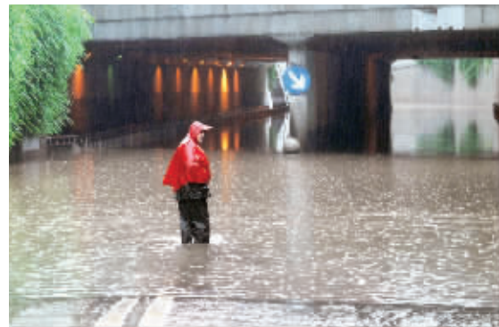
11时20分，长沙白沙路与芙蓉路交界的涵洞被封锁，积水最深处有一米多深，市政工作人员在现场紧急抢险。
