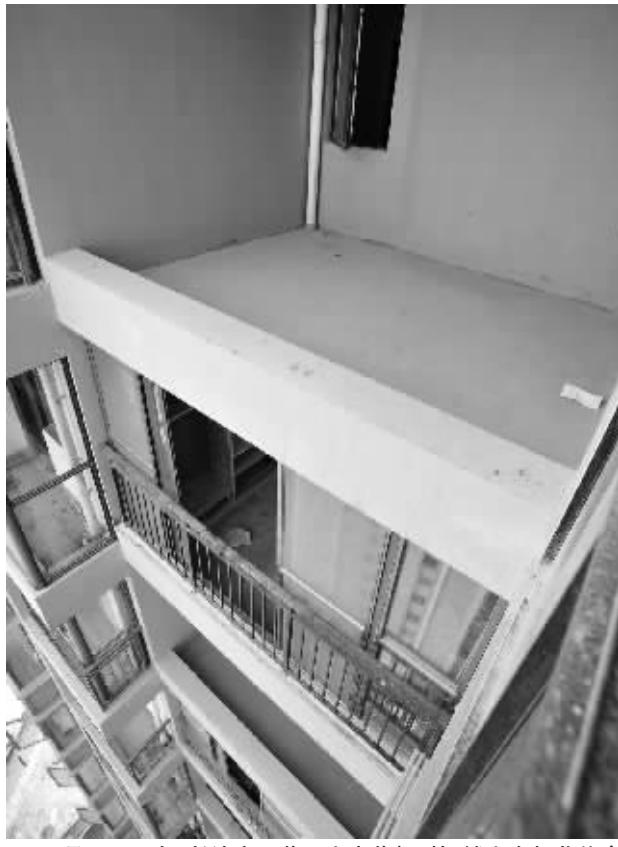
5月11日下午,长沙市雨花区山水花都2栋,楼上有些住户已将消防平台用铝合金封闭起来。 记者 田超 摄
