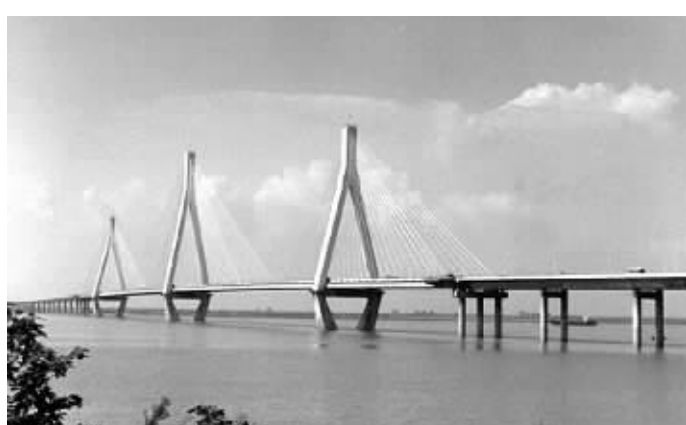
岳阳洞庭湖大桥,未来的湘府路大桥有望修成这样的三塔斜拉桥。
