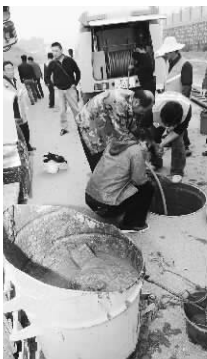
3月31日,长沙市金海路,新型管道疏通车不用工作人员下井。 记者 龚磊 摄
