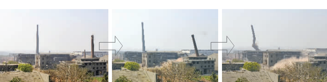
起爆瞬间,58米高烟囱顶端率先腾起灰尘。
