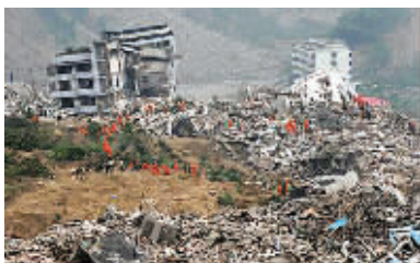
太子港建筑物在地震中受损严重。
