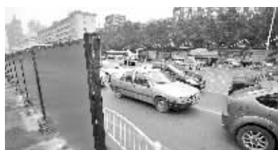
1月13日,五一大道迎宾路口,因修建地铁,该路段常有塞车现象发生。
