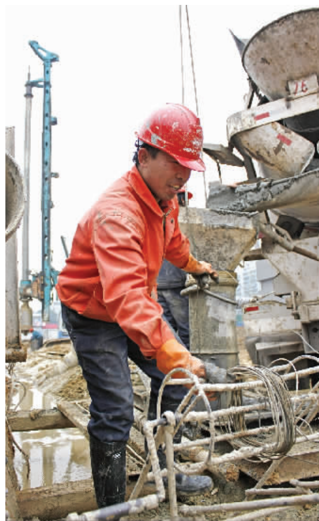
2009年12月31日,长沙汽车西站旁的地铁站施工工地上,侯瑞祥正在灌注混凝土。实习生 龙岱林 记者 田超 摄
