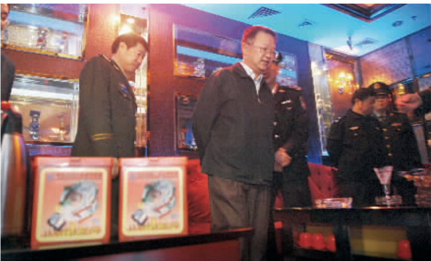
12月24日,解放西路,副省长刘力伟(中)一行对酒吧、KTV消防设施进行抽查。 记者 范远志 摄
