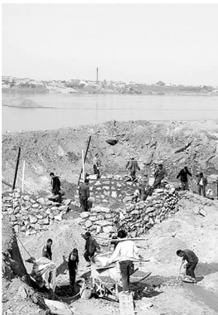
11月26日,湘潭三水厂附近,施工人员正在加紧修建一个5米深的二级提水井。届时,即使水位降到23米左右仍可实现取水。 记者 刘晓波 摄
