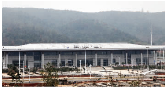
正在施工中的武广新郴州火车站。记者 龚磊 摄
