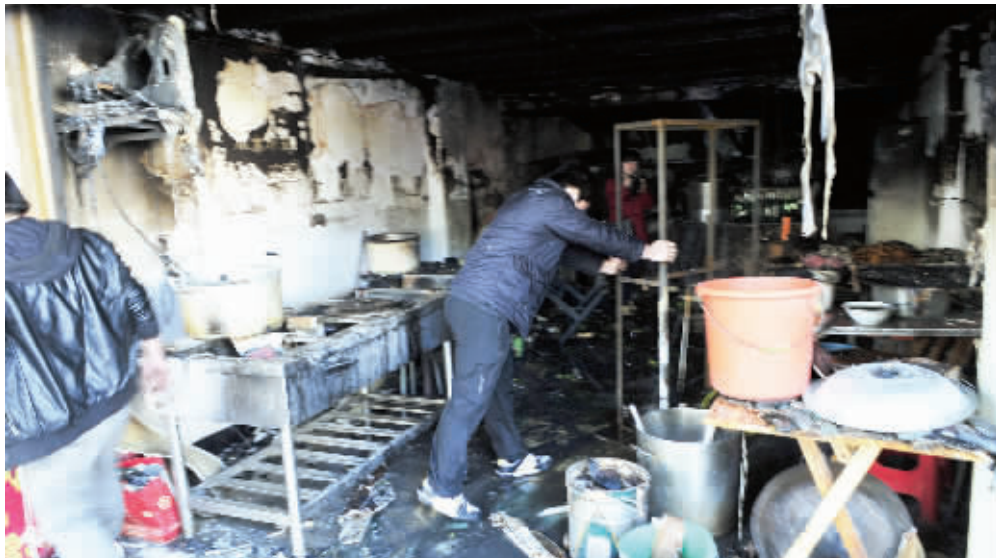
11月24日上午,长沙市开福寺路一家饭店起火被毁,店主在店内寻找未被烧坏的东西。记者 童迪 摄
