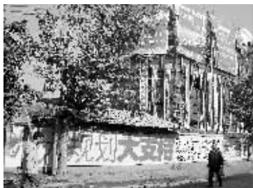
一个完全违法的建筑居然打起了“大规划、大支持”的标语。
