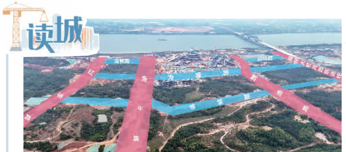
由湘江集团湘新投公司建设的“三纵四横”路网是湘江科学城首开区的重要交通配套。
