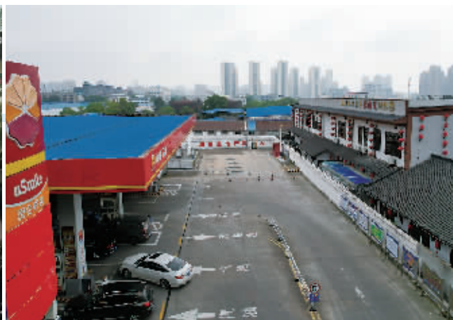
与饭店一墙之隔的加油站。记者 杨洁规 摄
