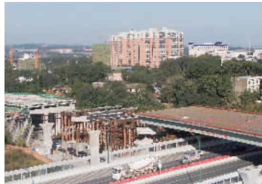
11月20日下午，在万家丽快速化改造北延线的高架桥主线横跨星沙联络线钢箱梁顶推施工圆满成功。 通讯员 供图
