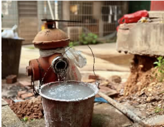
长沙某小区提质改造正在消火栓违规取水。
