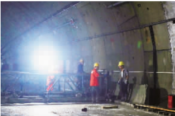
8月9日,湘雅路过江通道项目隧道内,作业人员正操作滚轮机进行道路铺装层的施工。 谢佳桀 摄
