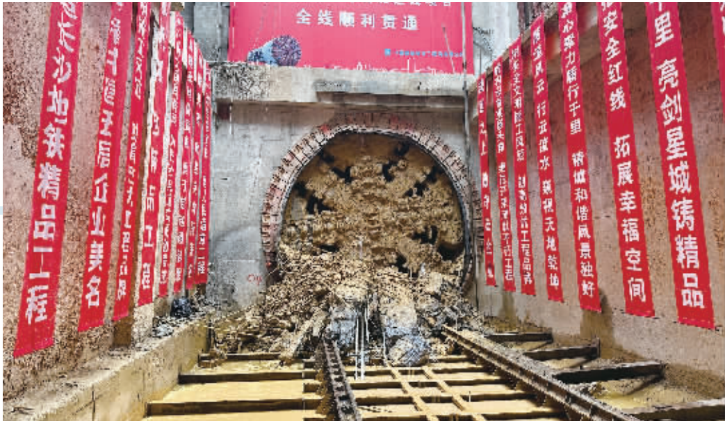
3月29日,鹅羊山站-秀峰山站左线盾构机顺利破洞而出。 通讯员 供图
