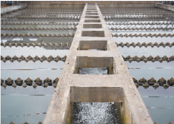
斜管沉淀池上层较清的水汇集进入中间的集水槽。
