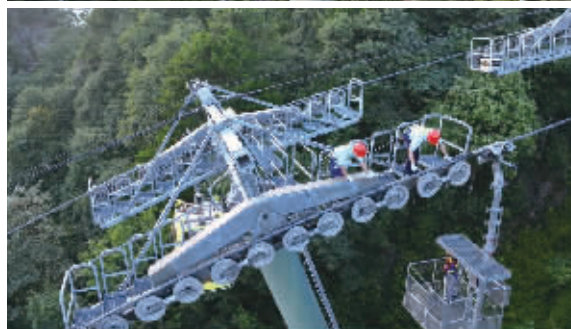
9月5日下午，张家界武陵源风景区杨家界索道，高明华和同事在塔架上进行日常检修。
