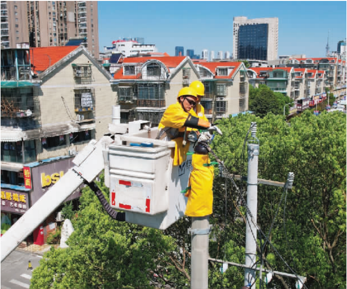
8 月 18 日上午 9 时，在长沙芙蓉区车站中路南湖大市场，国网长沙带电作业中心带电二班工作人员头顶烈日高温，在 10 千伏颜家咀线 408 号杆采取不停电作业方式对线路进行解分支引线工作，保障了线路正常运行，解决了市政渠水改造项目用电问题。国网长沙带电作业中心坚持“能带不停”原则，全力支撑城市基础建设，不断提升客户满意度和获得感。截至 7 月 31 日，累计已完成配网不停电作业 2270 次，多供电量 954.2 万千瓦时。
