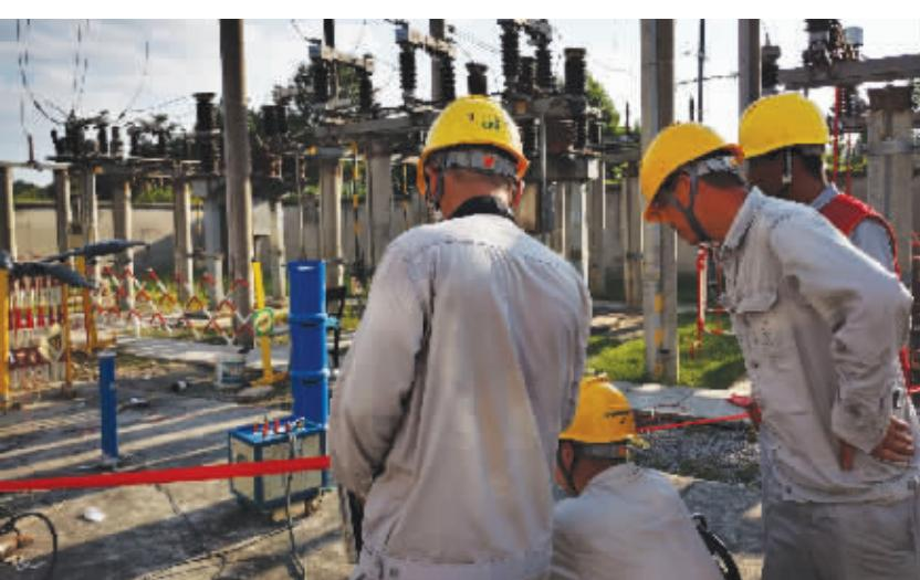
国网永州供电公司积极应对高温晴热天气，多措并举开展迎峰度夏保供电工作。提前成立“迎峰度夏”工作领导小组，建立六个工作专班，合理安排电网运行方式，强化电气设备特巡、测温工作，对变电站设备开展全方位巡视，确保电力设施安全稳定运行。图为7月18日，国网永州供电公司员工在35千伏福田变电站对站用变压器4X18电缆头进行发热消缺工作。
