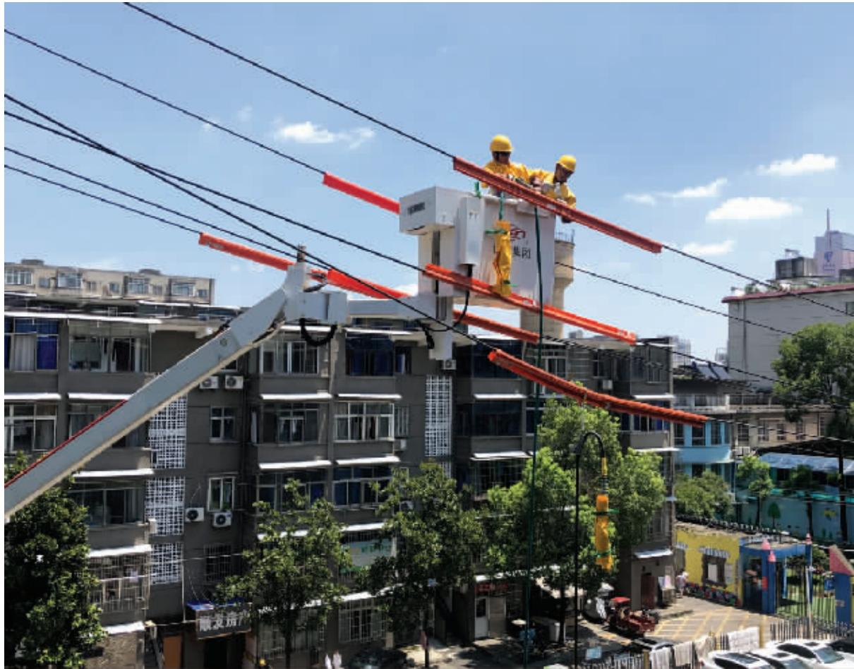
炎炎夏日,为保障长沙广大市民安全可靠用电,国网长沙供电公司带电作业持续开展。7月12日上午11时许,室外温度35摄氏度,地面温度达到了40摄氏度。在长沙市芙蓉区车站路一处配网施工现场,国网长沙带电作业中心工作人员在烈日下,身着长袖工作服,再套上一件由14层材料编织而成的绝缘服,在15米高空开展综合不停电作业,全力确保周边居民电力可靠供应。据现场负责人介绍,今年以来,国网长沙带电作业中心已开展不停电作业次数2072次,多供电量880.1万千瓦时,减少停电时户数63610时户。迎峰度夏期间,该中心8个作业组共80多名带电作业人员迎战高温,在全长沙市区内积极开展带电作业,确保广大居民清凉度夏。
