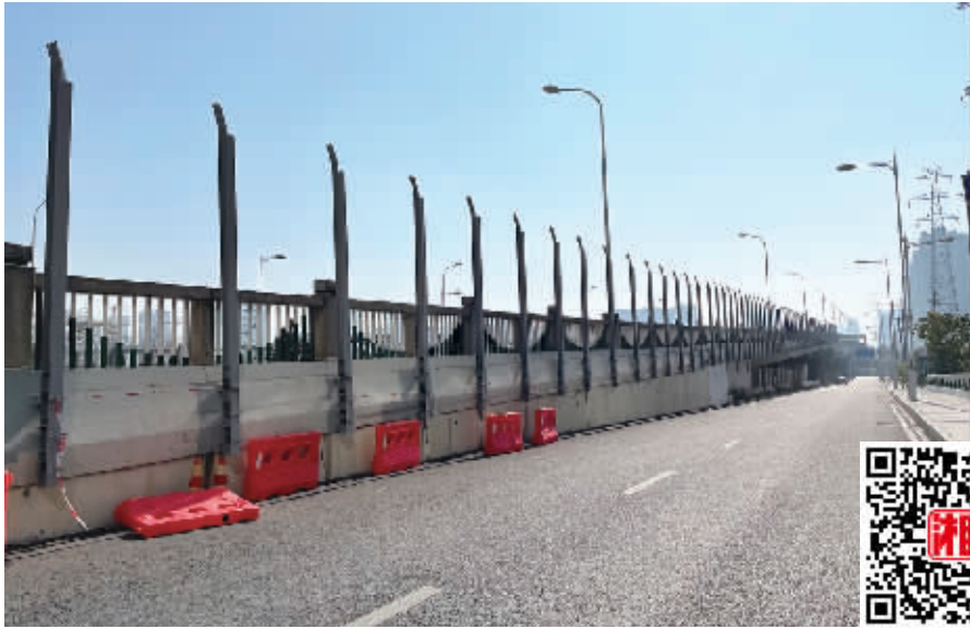
長沙開福大道瀏陽河大橋正在安裝聲屏障。 楊潔規 攝
