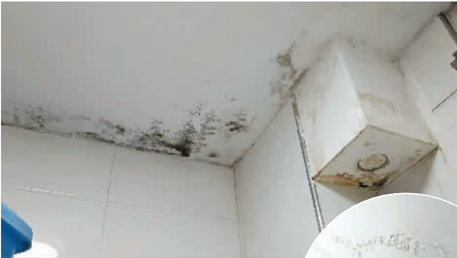
12月15日，在长沙市高新区保利麓谷林语小区，由于楼上漏水，导致楼下肖先生家天花板多处发霉起泡。
