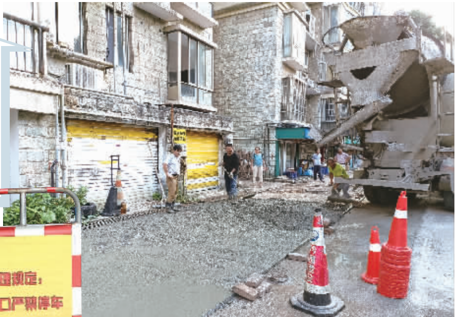
9月28日,在长沙市开福区金色比华利小区,小区沥青路面正在进行提质改造。修路所花费的钱均来自公共收益,没有动用一分钱维修基金。 记者 杨昱 摄
