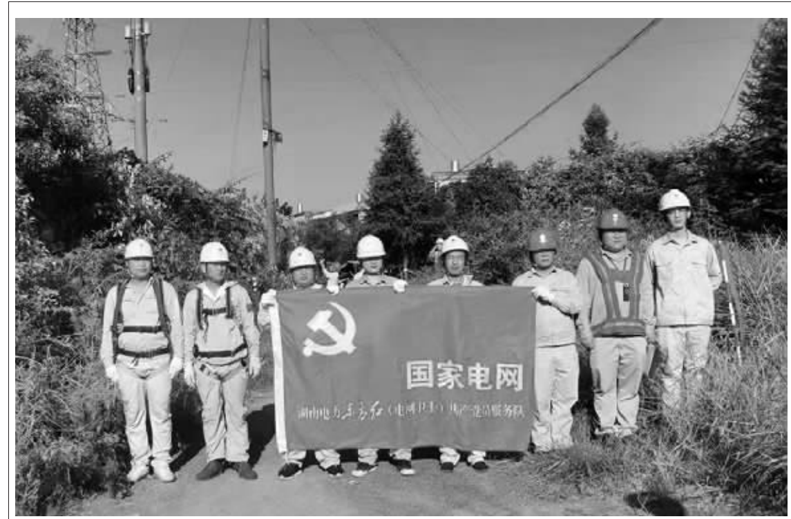
9月3日至24日,国网永州供电公司组织变电检修专业70余人对220千伏钵都变电站开启整站检修工作,全力服务地区招商引资。期间,220千伏钵都变电站用电负荷全部转移到110千伏蒋明珠线。省、市、区三级供电公司高度重视,对该线路进行联合保电,通过带电作业方式顺利完成发热缺陷治理工作,为接下来的线路保电工作奠定了坚实的基础。经过1小时左右的紧张作业,消缺工作顺利结束,测温结果正常,为蒋明珠线安全稳定运行提供了重要保障。省、市、区三级供电公司作业人员同心协力,学史力行,“我为群众办实事”,以实际行动践行了“人民电业为人民”的企业宗旨。
