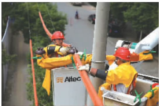
迎峰度夏期间,国网常德供电公司积极开展带电作业。(彭浩摄)
