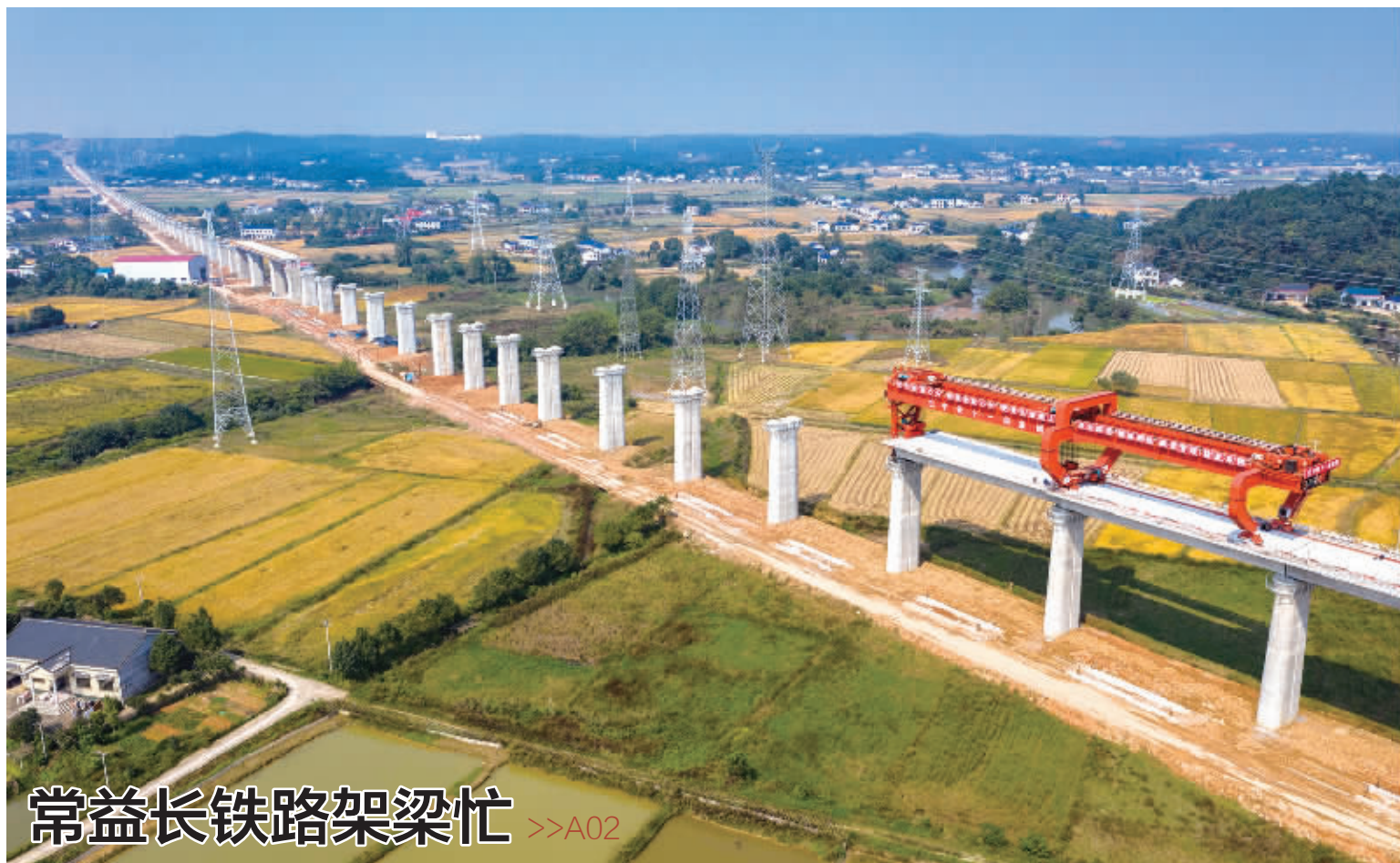
10 月 11 日拍摄的常益长铁路八曲河特大桥梁架梁现场(无人机照片)。目前, 常(德)益(阳)长(沙)铁路益长段进入架梁高峰。常益长铁路正线全长约 157 公里, 设计时速为 350 公里, 是国家“八纵八横”高速铁路网的重要组成部分, 其中益长段正线全长约 65 公里。 新华社 图
