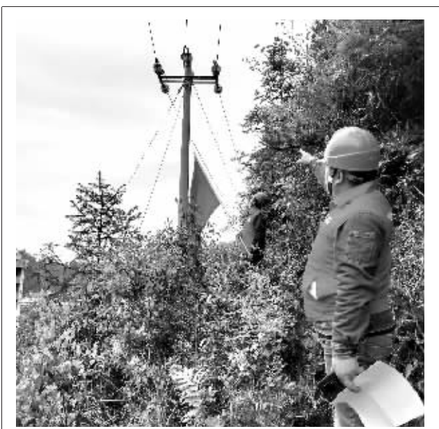
国网桂东县供电公司沙田供电所共产党员突击队开展“旗帜领航 配网攻坚”10千伏青彩线集中检修。■撰文/摄影 陈乐平
