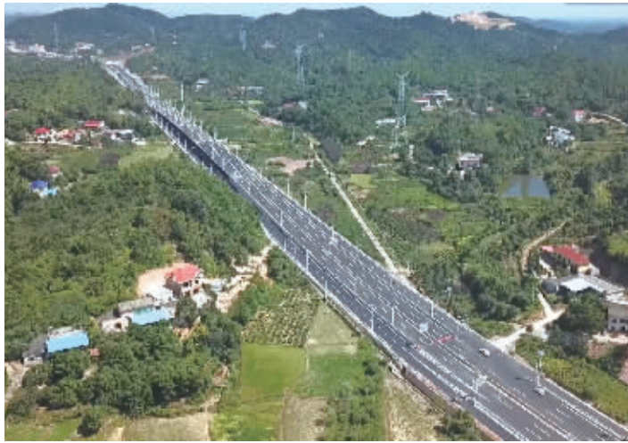
8月28日上午，作为长株潭“三千两轨”项目之一，全长30.1公里的洞株城际快速路全线通车，长沙到株洲最快仅需28分钟。 长沙交通集团 供图
