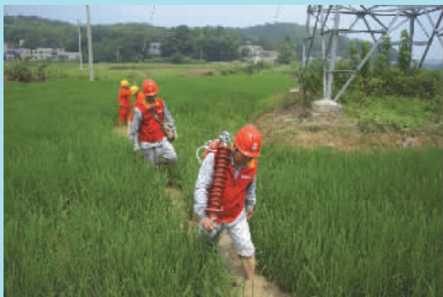
8月8日,湘潭供电公司共产党员服务队开展新路集中检修。
