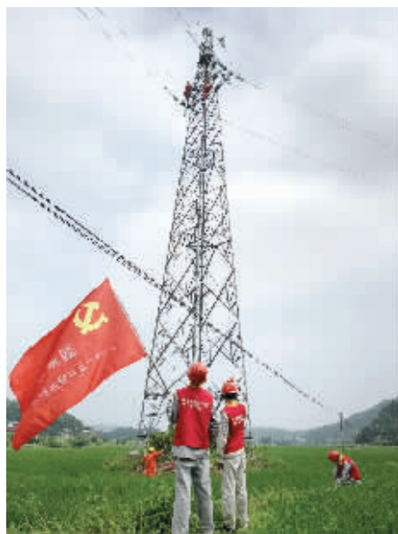
8月22日,湘潭供电公司共产党员服务队奋战在检修第一线。
