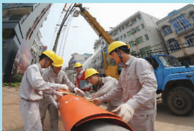
8月23日,湘潭供电公司开展带电立杆作业,减少用户停电时间。
