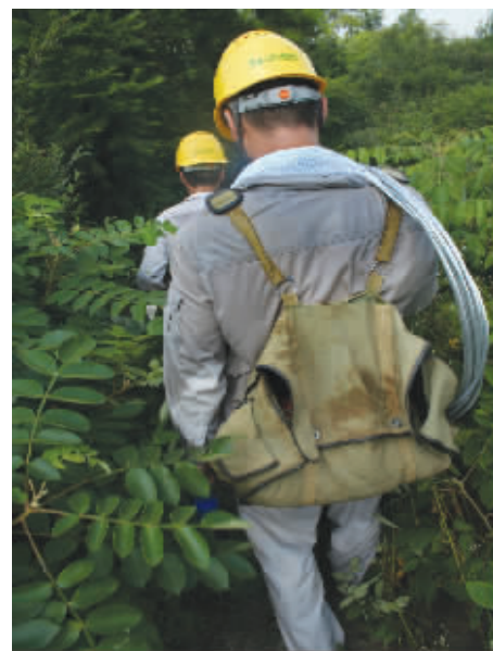
8月25日,湘潭供电公司特巡员工冒着高温巡视输电线路。
