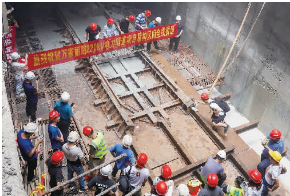
万家丽路220KV电力隧道工程施工现场。记者 王珏 摄
