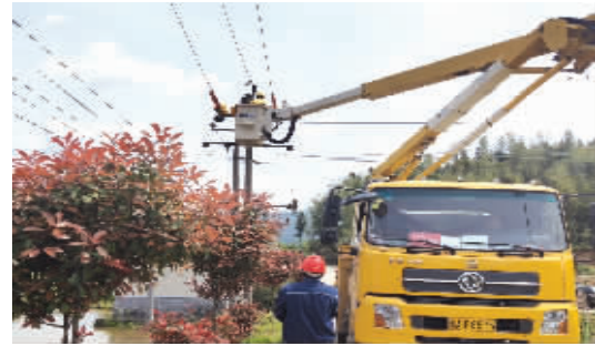
4月11日,国网浏阳市供电公司员工在10千伏小河线石马支线开展带电作业抢修,更换受雷击损坏的绝缘子。(唐焕良)
