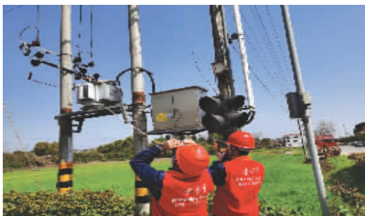
3月20日,国网长沙县供电公司10千伏高沙线开展春安检查巡视工作。(邓倩)
